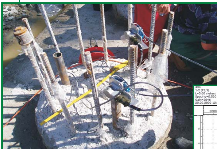
měření integrity piloty aparaturou CHA
