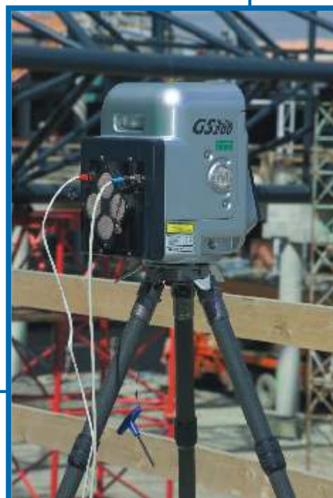
Podrobná kontrola přesnosti montáže nosné konstrukce stěhy
