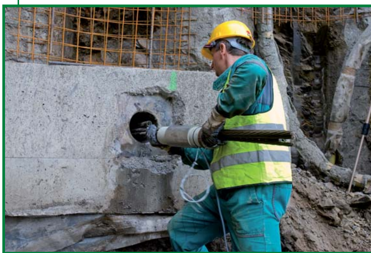
instalace snímače na zemní kotvu
