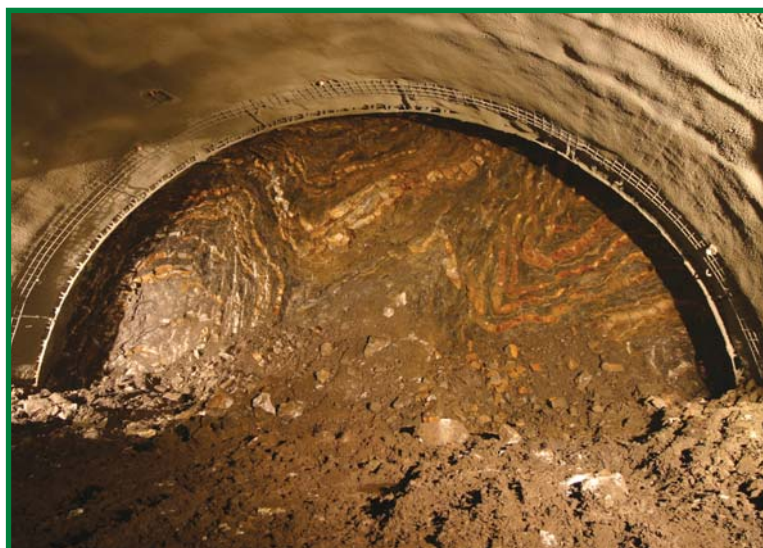
geologické sledování a dokumentace čelby
